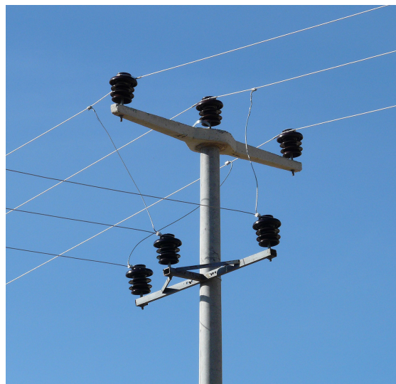
Oben: Besonders viele Unfälle geschehen bei Masten mit Stützisolatoren und Leitern oberhalb des Querbalkens.
