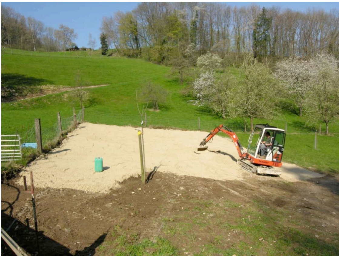
Abb. 2: Mageres Substrat (Lägerol) wird auf der geschürften Fläche verteilt
